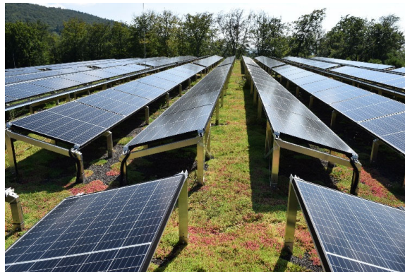
Gründach mit Photovoltaik © Optigrün International AG
