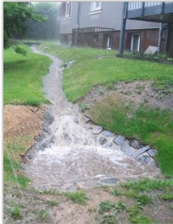
Versickerungsmulde bei Starkregen in Solingen © Kopperschmidt
