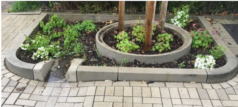
Regenwassereinleitung in Baumscheibe © Kopperschmidt
