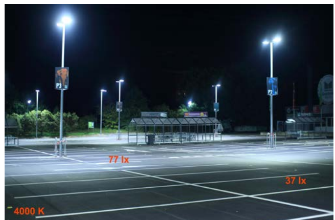
Abb. 3.3: Links ein Parkplatz mit 7 - 16 lx Beleuchtungsstärke und warmweißer (3.000K) LED-Beleuchtung, rechts einer mit 35 - 75 lx Beleuchtungsstärke und neutralweißer (4.000K) LED-Beleuchtung. In beiden Fällen wurde eine voll abgeschirmte Beleuchtung installiert. Links ist die Beleuchtung an die Norm angelehnt, rechts sind wesentlich höhere Lichtmengen eingesetzt. Da der rechte Parkplatz nach Geschäftsschluss kaum genutzt wird, ist ohnehin fraglich, ob er dann noch so hell beleuchtet sein muss.
