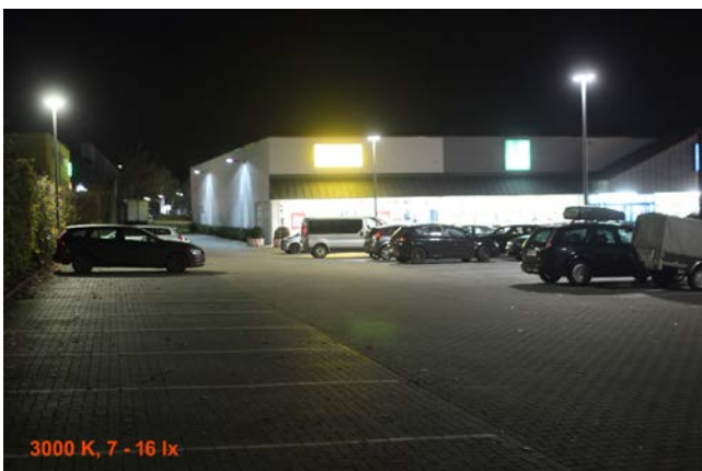
Abb. 3.3: Links ein Parkplatz mit 7 - 16 lx Beleuchtungsstärke und warmweißer (3.000K) LED-Beleuchtung, rechts einer mit 35 - 75 lx Beleuchtungsstärke und neutralweißer (4.000K) LED-Beleuchtung. In beiden Fällen wurde eine voll abgeschirmte Beleuchtung installiert. Links ist die Beleuchtung an die Norm angelehnt, rechts sind wesentlich höhere Lichtmengen eingesetzt. Da der rechte Parkplatz nach Geschäftsschluss kaum genutzt wird, ist ohnehin fraglich, ob er dann noch so hell beleuchtet sein muss.
