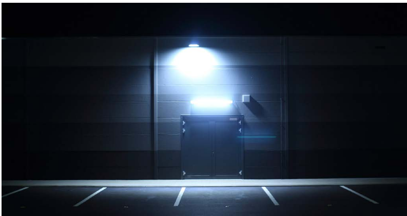
Abb. 3.17: Unnötige Doppelbeleuchtung mit neutralweißen LED: Oben ein Planflächenstrahler, der nur nach unten strahlt, während darunter zusätzlich eine LED-Röhre installiert ist, die ihr Licht in alle Richtungen abstrahlt und blendend wirkt.
