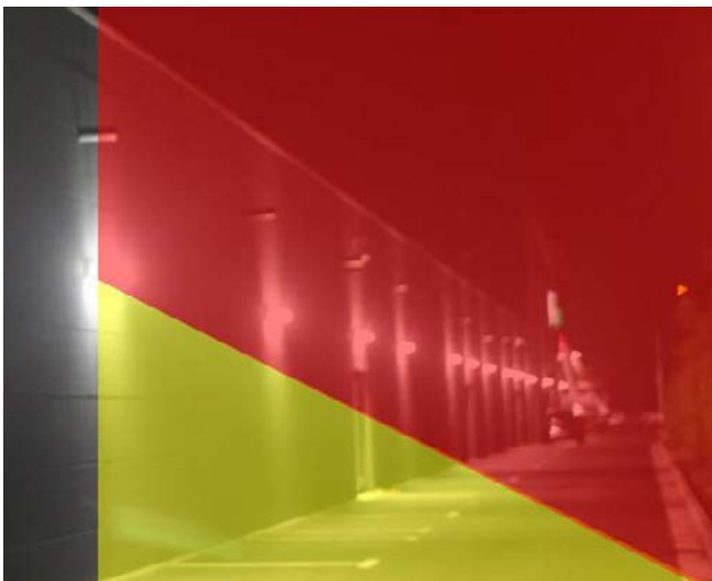
Abb. 3.21: Links: Die Wandleuchten strahlen rundherum ab, lediglich ca. 20 – 30 Prozent des abgestrahlten Lichts wird auf der Verkehrsfläche genutzt (gelb). Rechts: Durch abgeschirmte Leuchten wird das Licht vor allem auf die Verkehrsfläche gelenkt.
