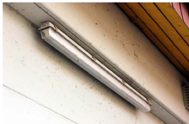
Abb. 3.18: Mit einfachen Mitteln umgebautes Gehäuse für LED-Röhren, das eine blendende Abstrahlung nach vorne vermeidet.
