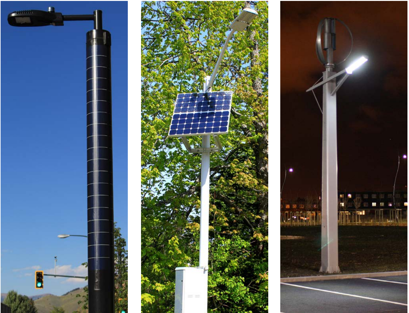
Abb. 1.5: Leuchten als Beispiele für die Nutzung regenerativer Solar- (links und Mitte: Photovoltaik) und Windenergie (rechts).
