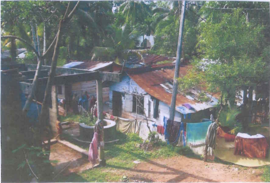
Toiletten für 13 vom Tsunami betroffenen Familien in Kankanagoda - Beruwala (SL)
